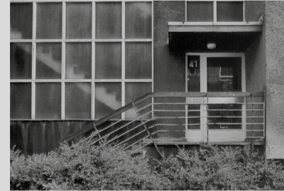
Fig. 3: Handrail, image taken for Der bewegte Betrachter , Station Bornholmer Straße, 1993
